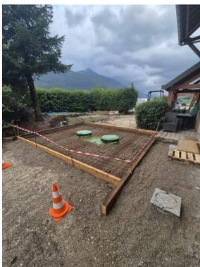
**Eau Potable** : L'école a mis en conformité son alimentation d'eau potable en lien avec la construction du restaurant scolaire avec la mise en place du compteur d'eau à l'extérieur du bâtiment dans une chambre de comptage normalisée.
