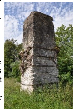
Vue de la cheminée d'équilibre de la conduite d'amenée. Photo Yannick Milleret
