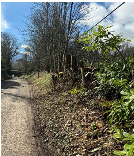
Elagage pour le déploiement de la fibre.
