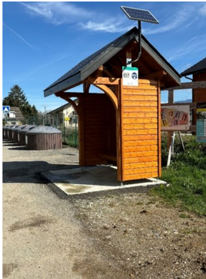
Pose d'un nouvel abri bus route de Saint Sulpice durant l'été
