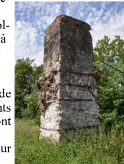
Vue de la cheminée d'équilibre de la conduite d'amenée. Photo Yannick Milleret
